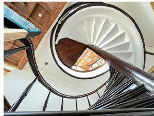
鉱山事務所内にある3階まで続くらせん階段
