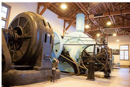
旧止滝発電所で使用されていた発電機
