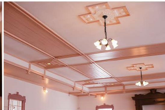
内壁は漆喰。建物内部のやさしいピンク色は、当時の色合いに基づいて塗装している
